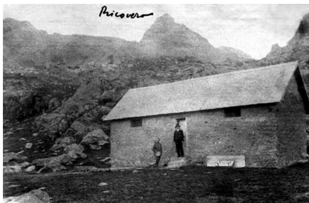
Fig. 5. Piero Barocelli con a fianco Edoardo Baglione, sulla porta, di fronte al ricovero presso il Lago Lungo Superiore, appena costruito. L'appunto autografo "Ricovero" è di Barocelli (da Fondo Barocelli, fald. 11).
